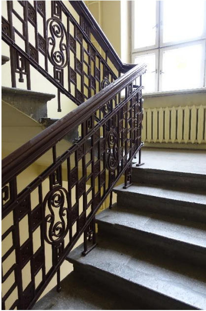
Klatka schodowa budynku frontowego
